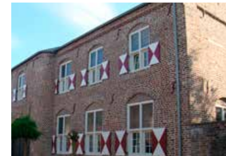
Historische Bausubstanz wurde feinfühlig rekonstruiert
